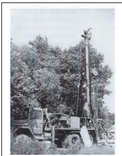
Brøndboremaskine ved Fuglekilde Høj
